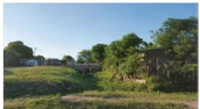
Zanjas a cielo abierto
