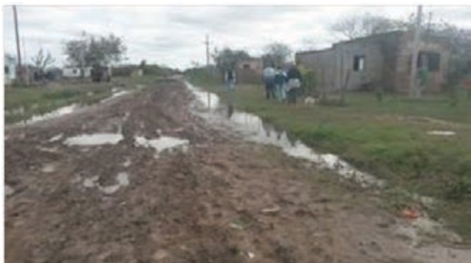
Red vial terciaria, sin pavimentar y con deficientes desagües pluviales
