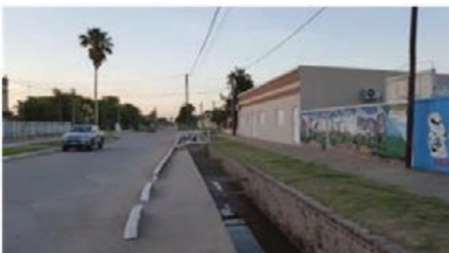
Canales a cielo abierto
