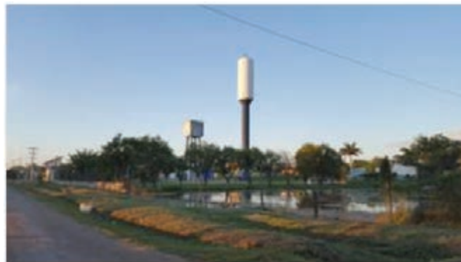
Instalaciones de SAMEEP, desborde permanente de agua al espacio público.
